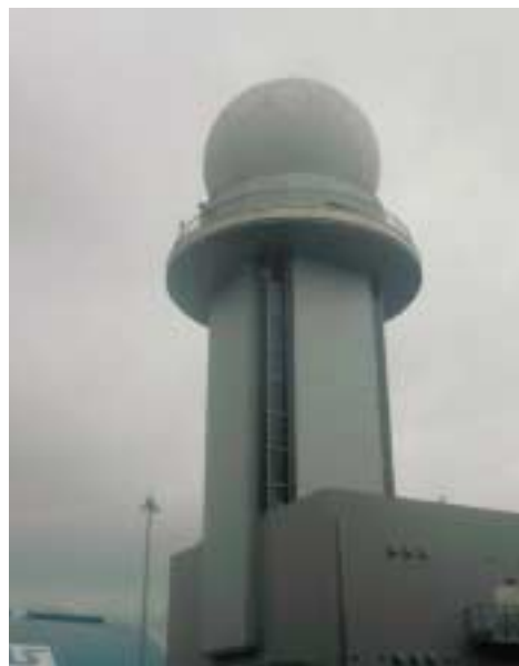
ドップラーレーダー局舎
