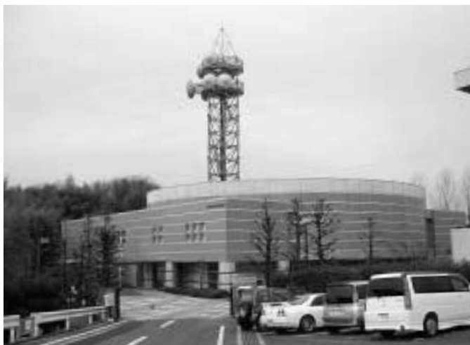
淀川ダム統合管理事務所
